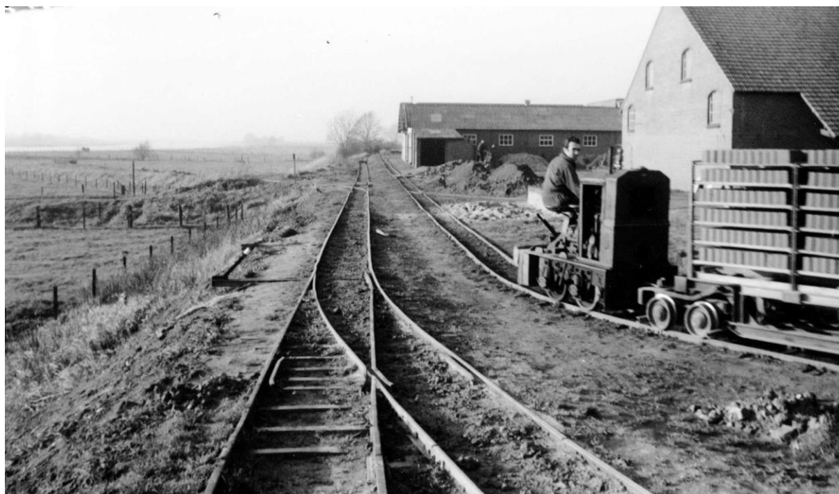
Figuur 109. Het spoor aan de zuidkant van de fabriek in 1968. Niet alleen klei maar ook de gevormde bakstenen worden over het spoor vervoerd. De aftakking naar links voert naar het winningsterrein (bron: Stichting Cultuurbehoud Milsbeek).
