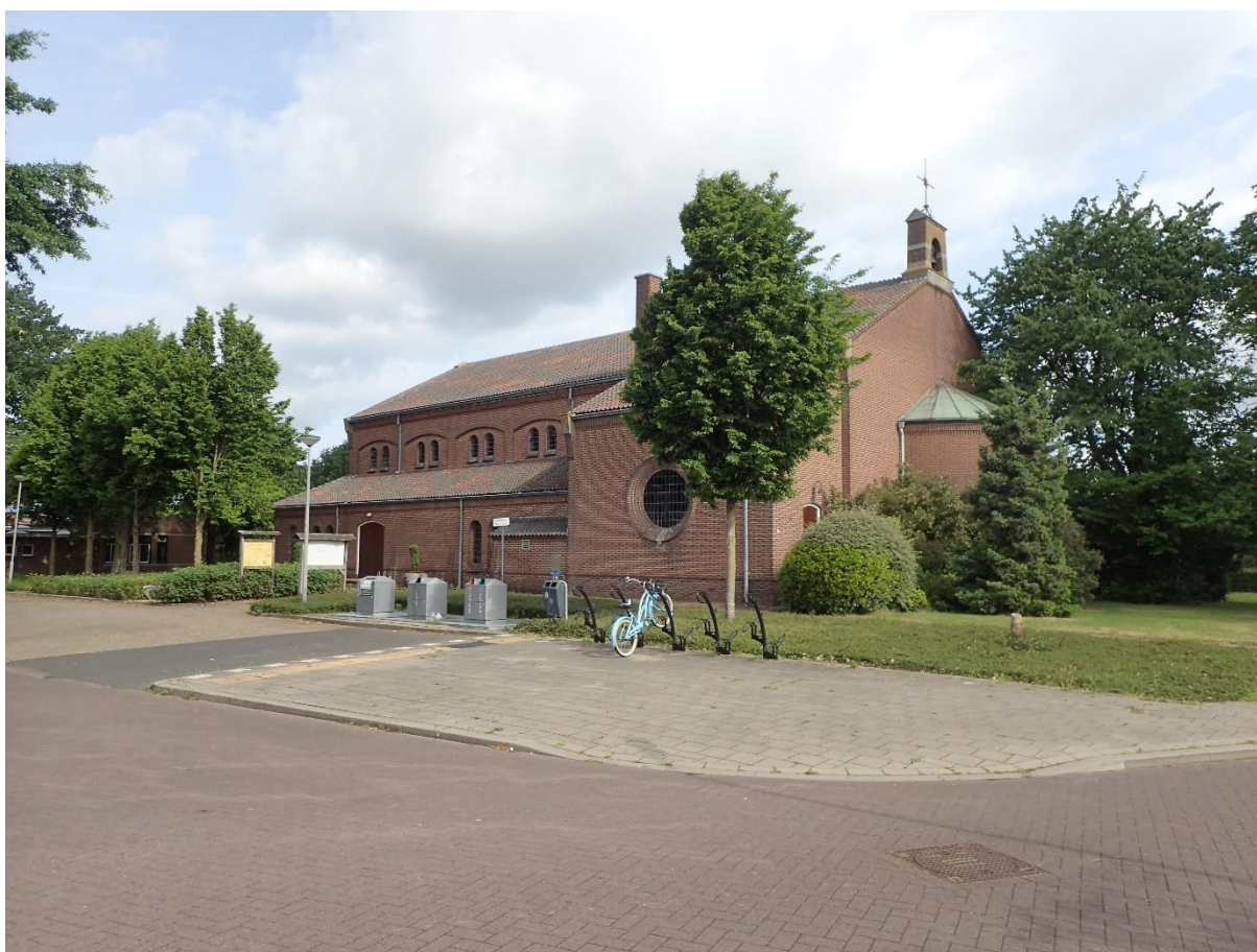
Figuur 42. De Antonius-Abtkerk van Ven-Zelderheide, één van de laatste uitingen van het Rijke Roomse Leven in de 'Lob van Gennep' (foto: RAAP, 27 mei 2022).
