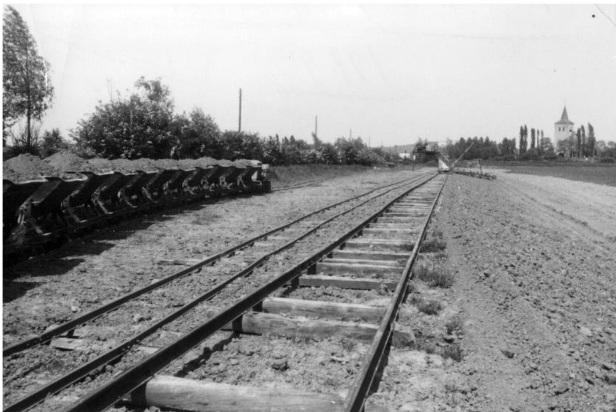
Figuur 104. Het breedspoor van de excavateur met ernaast het smalspoor van het transport-treintje op de Huisse Wei bij Middelaar in 1959. Langs de struiken links ligt de weg naar het Middelaarshuis (bron: Stichting Cultuurbehoud Milsbeek).
