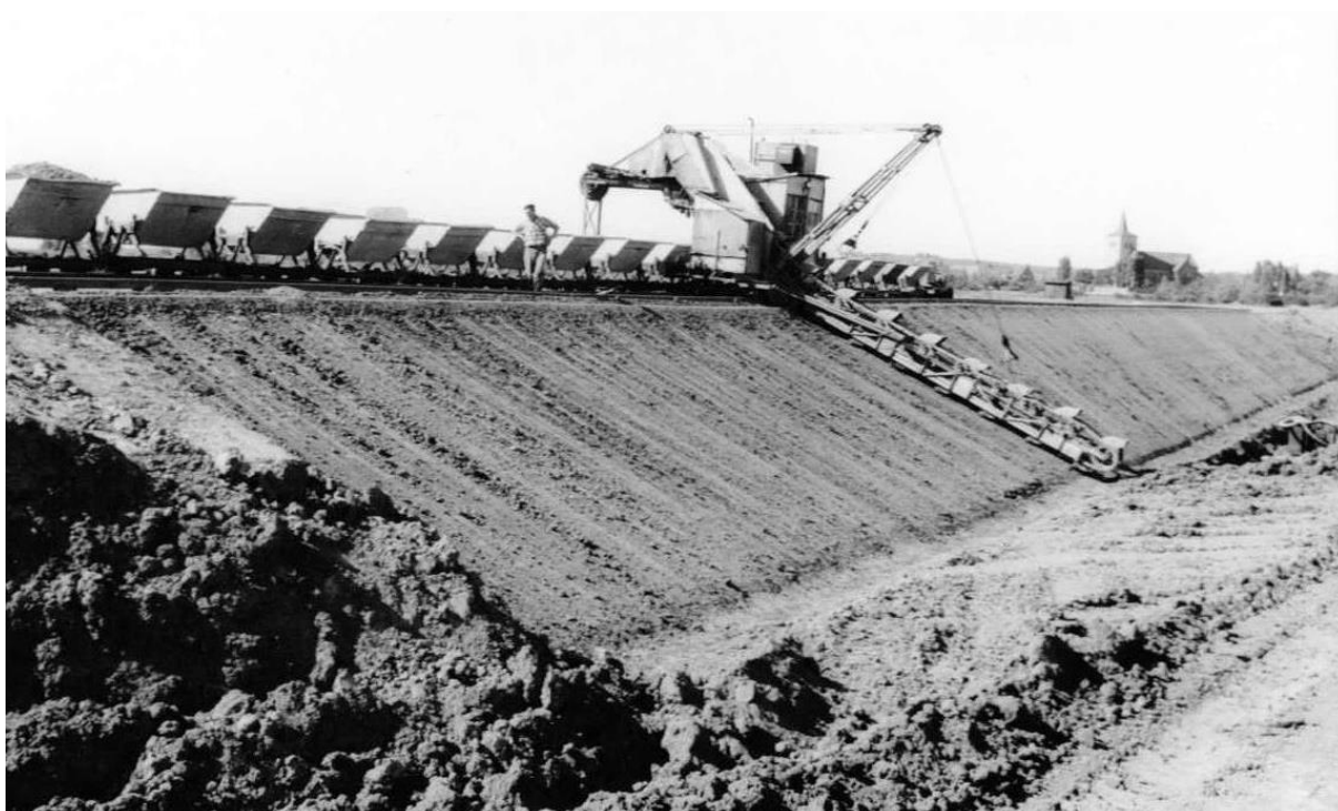
Figuur 105. De excavateur aan het werk op de Huisse Wei bij Middelaar. De klei werd tot op grote diepte afgegraven (bron: Stichting Cultuurbehoud Milsbeek).
