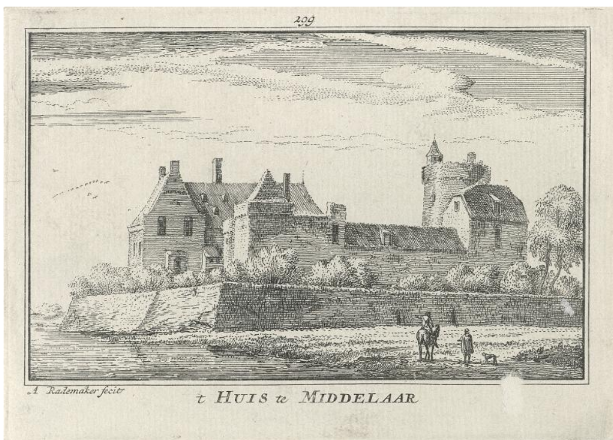
Figuur 75. Huis Middelaar, hier gezien vanuit het oosten, een versterkt huis met zelfs een aarden wal, zoals vastgelegd door Abraham Rademaker rond 1730. Onduidelijk is of dit de situatie van die tijd weergeeft of een weergave van een oudere staat van het kasteel. Zie ook figuur 76. (bron: Rijksmuseum.nl & KastelenInNederland.nl.)
