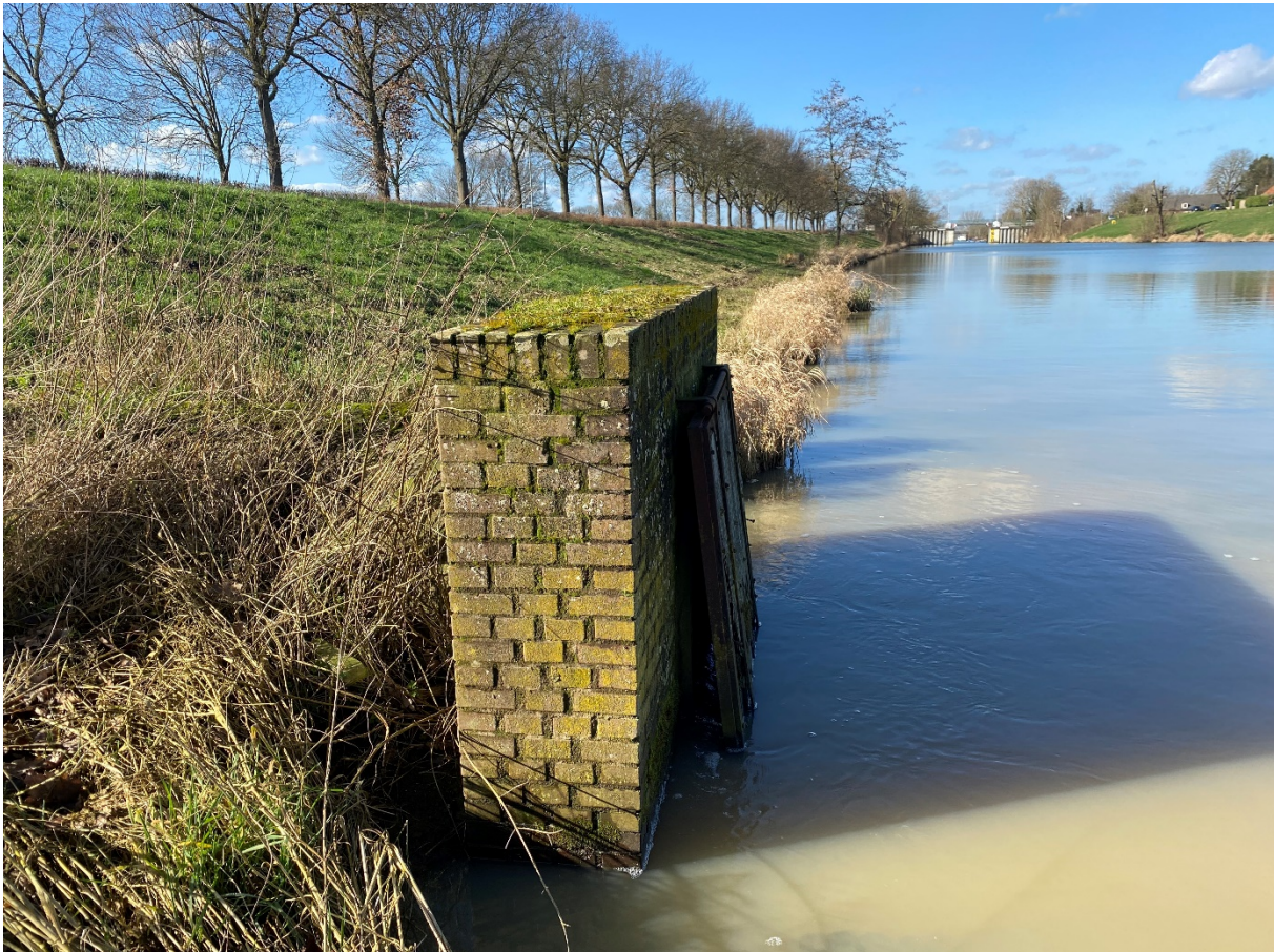
Figuur 26. Gemetselde uitgang van de duiker met terugslagklep aan het Mooks Kanaal. Op de achtergrond de keersluis Mook (foto: RAAP, 23 februari 2022).
