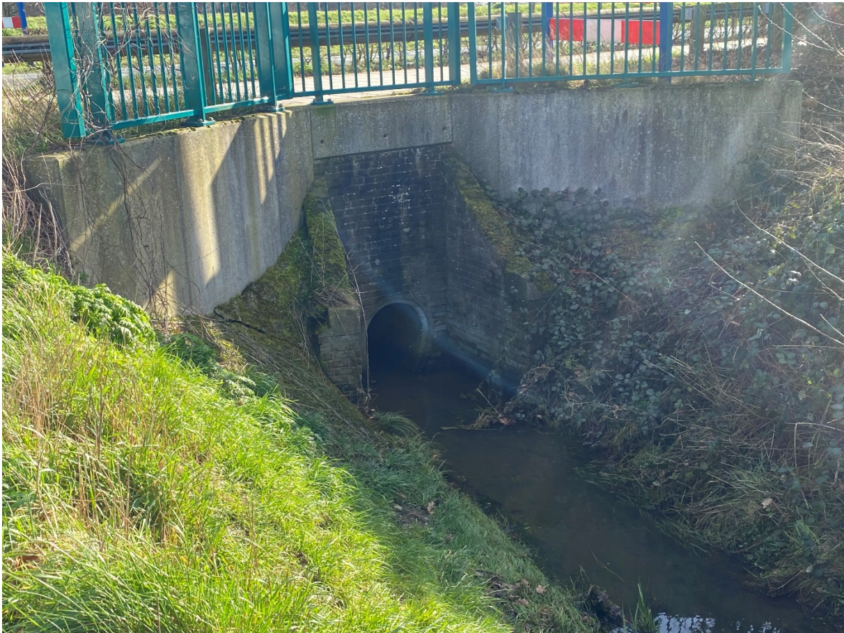
Figuur 27. Gemetselde duiker ten oosten van Ven-Zelderheide. In 2011 is bij de aanleg van het fietspad het betonnen bovendeel aangebracht (foto: RAAP, 23 februari 2022).
