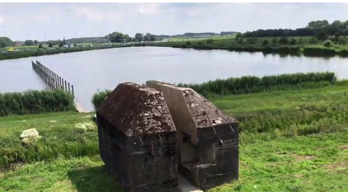
Kazemat, Diefdijk 20 e eeuw, Beleefbaar maken door weghalen
