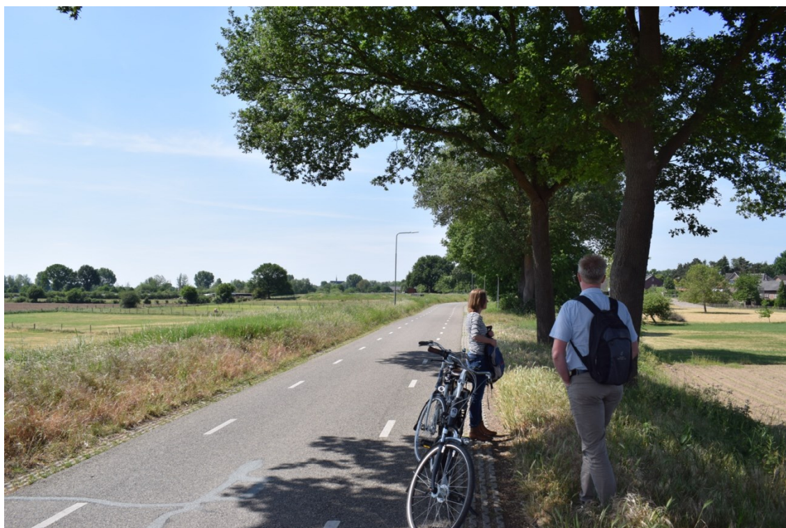
Afbeelding 14: De Voordijk in Middelaar sluit een oude hoogwatergeul af en kent een karakteristieke laanbeplanting in het binnentalud
